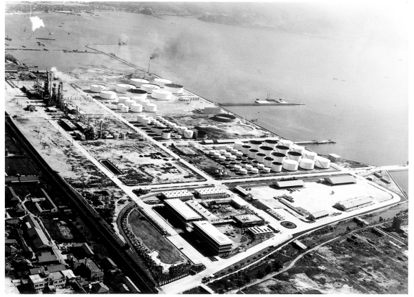
竣工時の徳山製油所 (© 出光興産)
